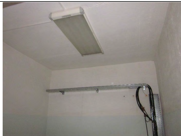
Внутренняя отделка помещения
