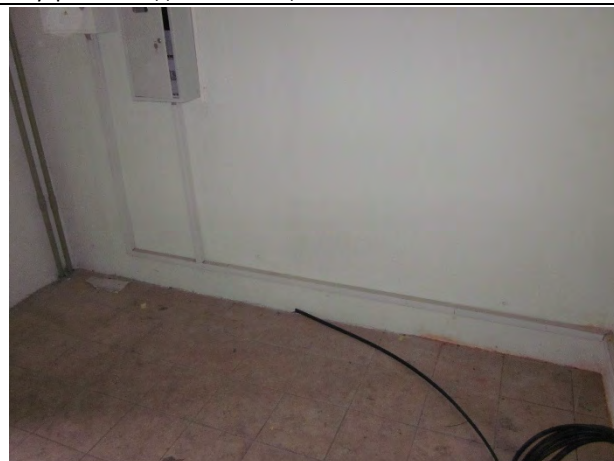
Внутренняя отделка помещения
