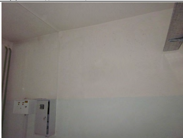
Внутренняя отделка помещения
